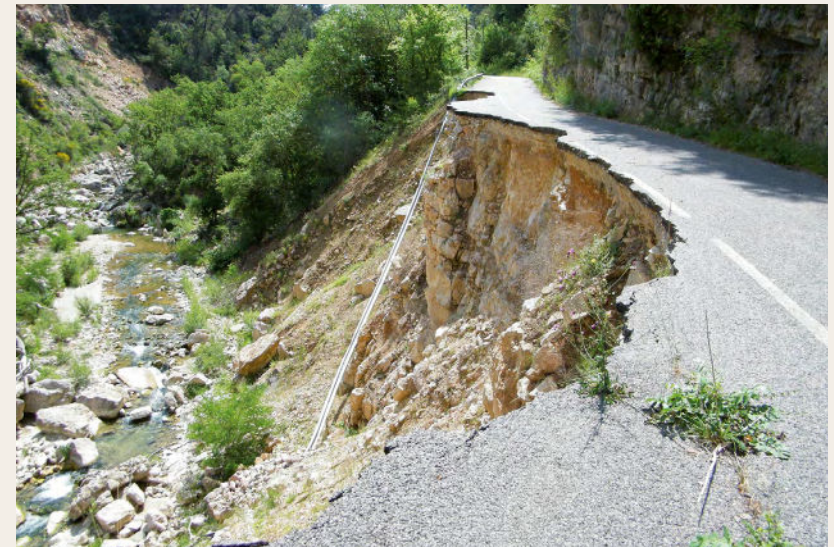
Effondrement de chaussée - © Cerema
